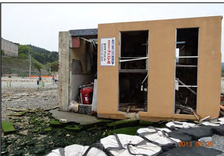
【津波で車庫に車が入ったまま倒れたスーパー】
