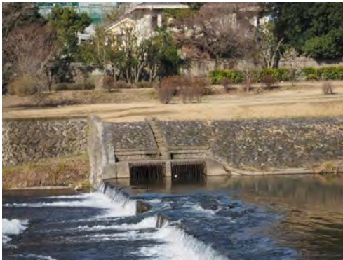
鴨川の暗渠への取込み口
